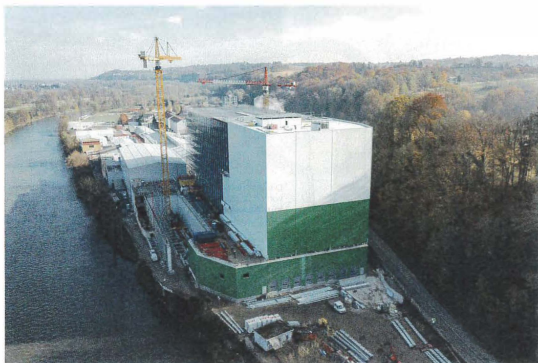
ECE-LOG errichtet das neue Lager direkt auf der neu gebauten Produktionshalle.
