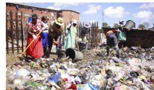
Müllbeseitigung vor und während der Revitalisierungsarbeiten Waste disposal before and during the revitalisation work
