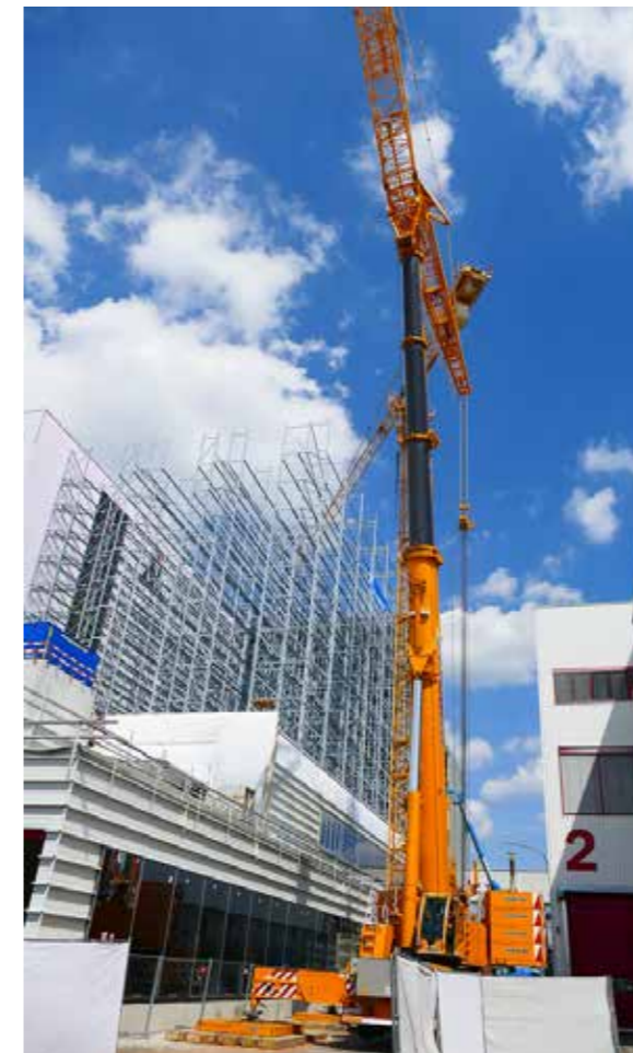
Bauen auf engstem Raum, Magna Steyr Graz Karosserielager Building in a tight space: Magna Steyr Graz car body warehouse
