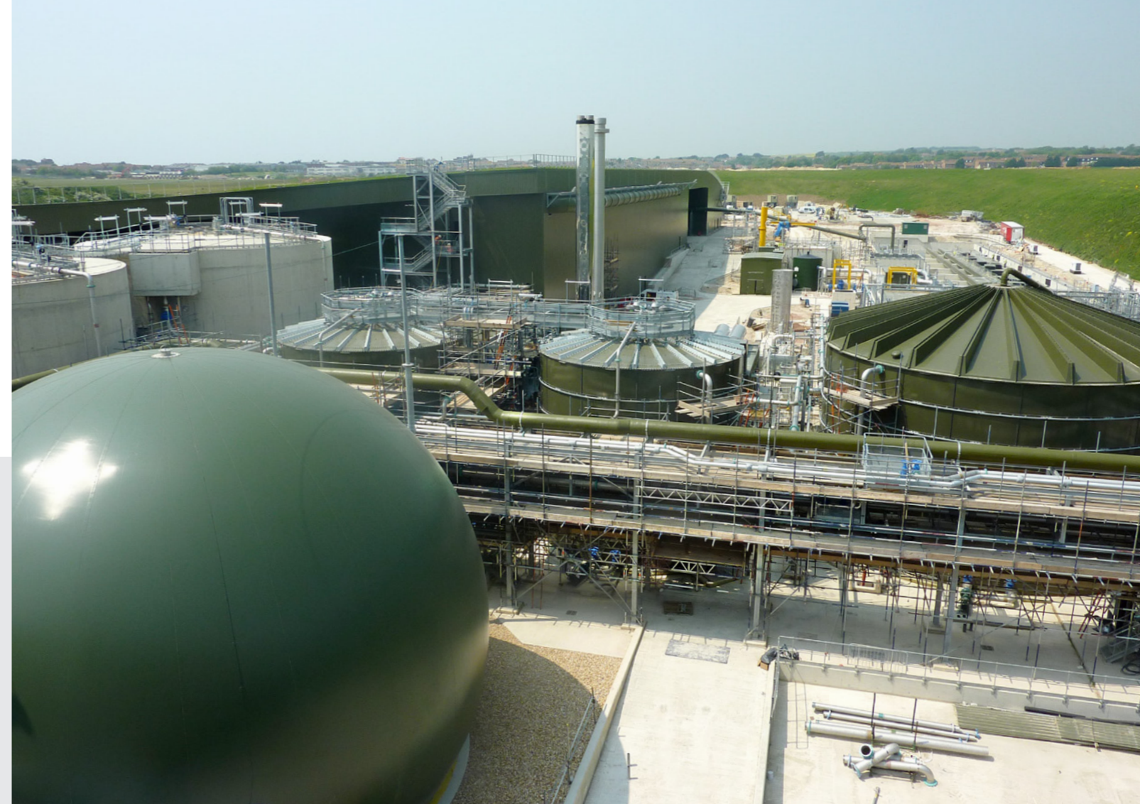
Gesamtansicht der Schlamm-trocknungsanlage: „Brighton & Hove Wastewater Treatment Project“
